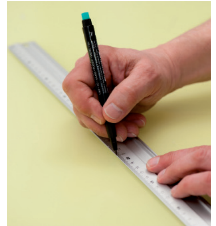
Aussparungen und Öffnungen auf der Folie anzeichnen und in den Schnittkantenecken stets vorbohren.
